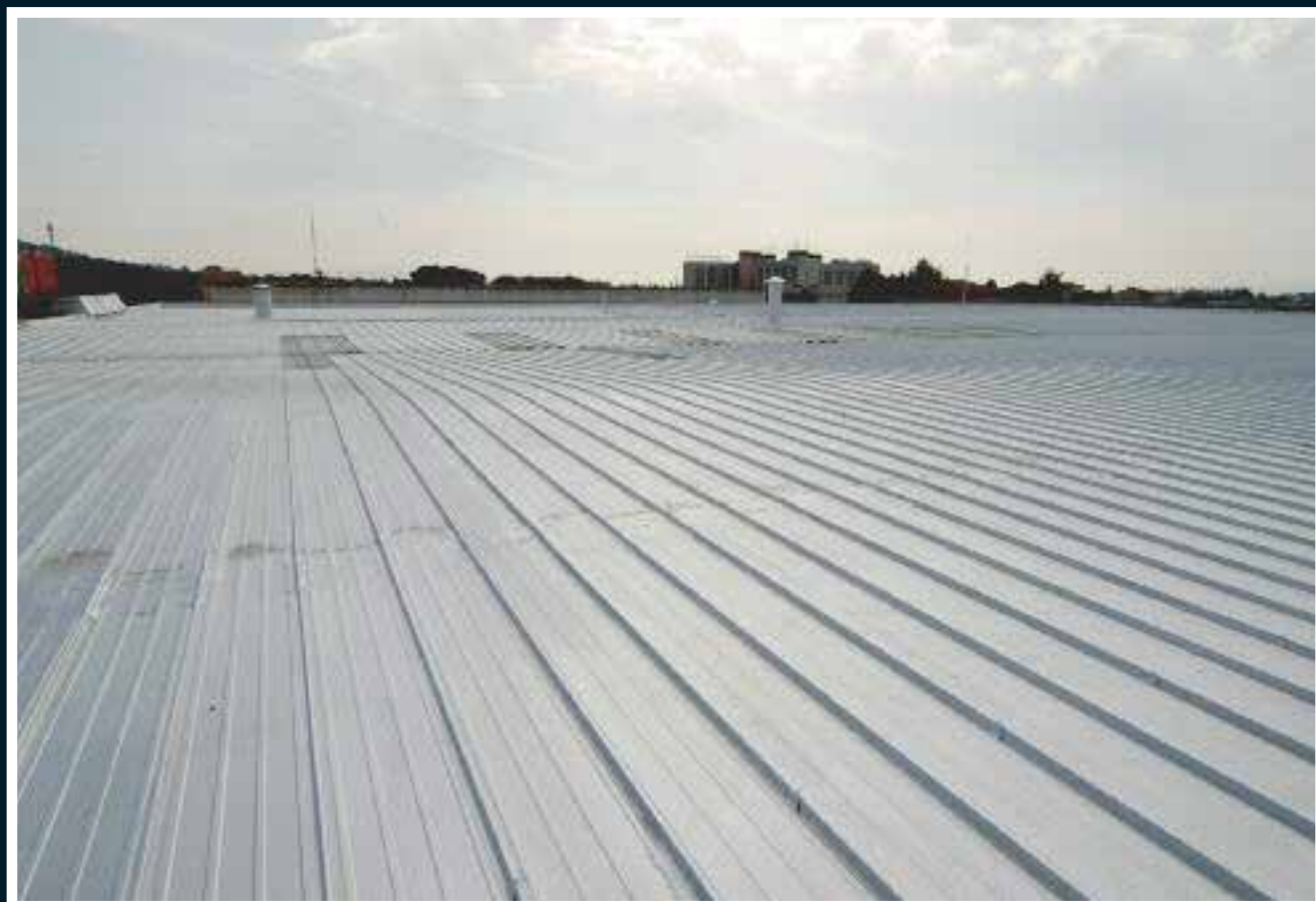
Aspecto de la cubierta metálica acabada después del tratamiento hecho con una mano de pintura de aluminio tipo Allumisol 12/14 pasada después de 20 días de la segunda mano de ElastiK (aplicación con pistola con un consumo total de 200 g/m 2 )
