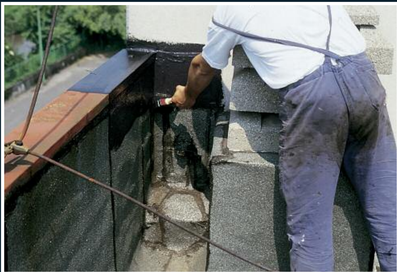
La impermeabilización de superficies irregulares
