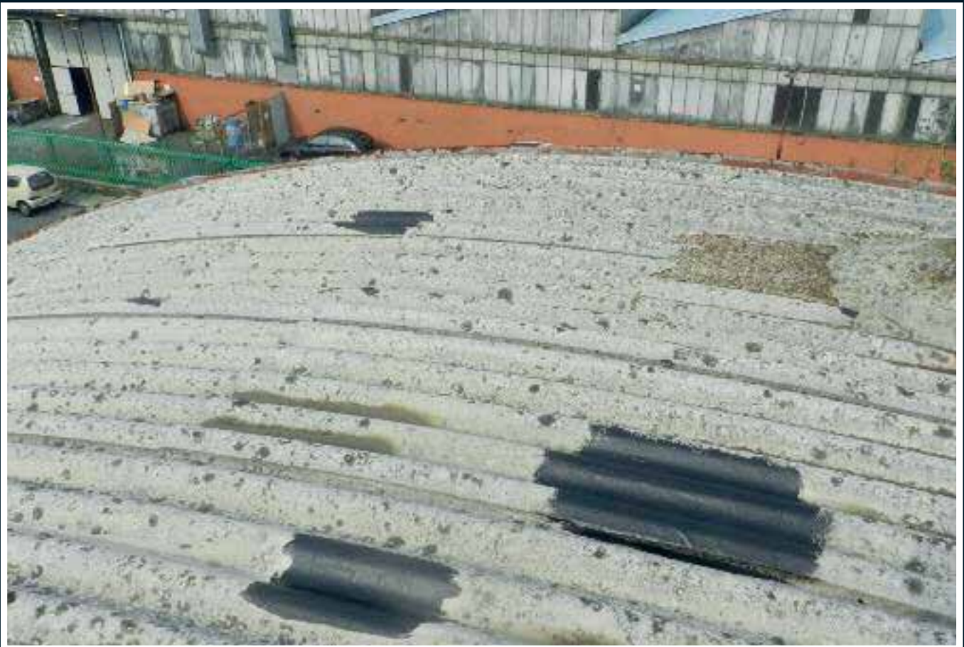
Resultado evidente de quiebre de la cubierta de fibrocemento debido al granizo
