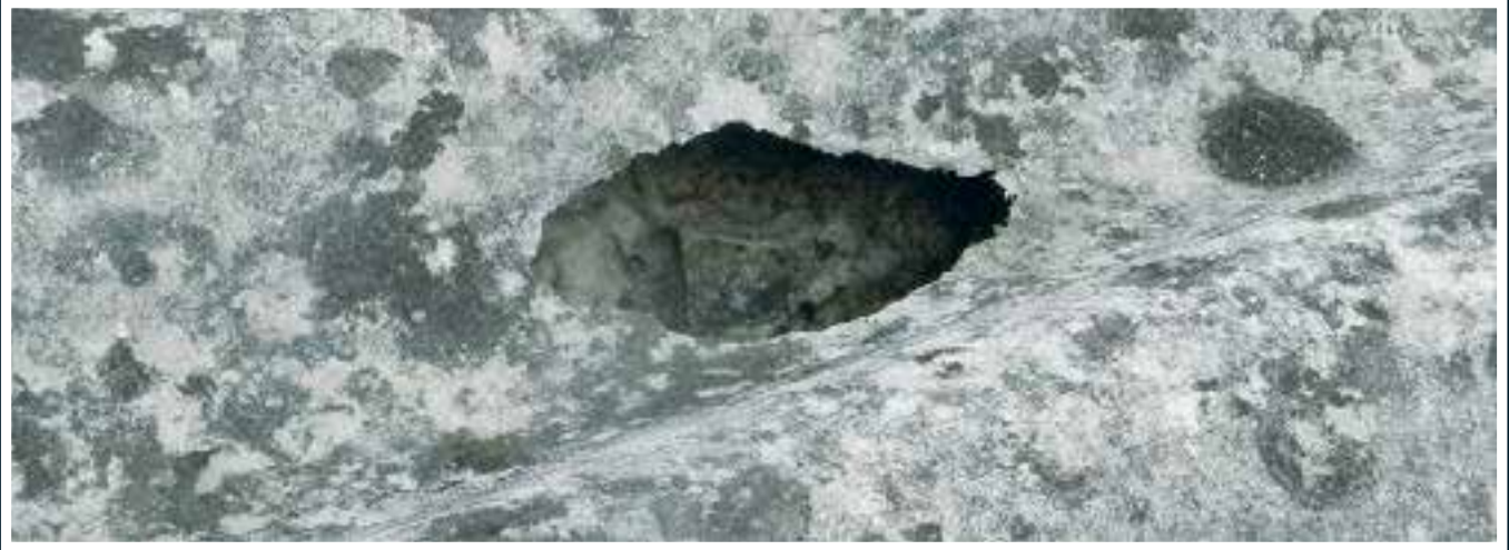
Resultado evidente de quiebre de la cubierta de fibrocemento debido al granizo
