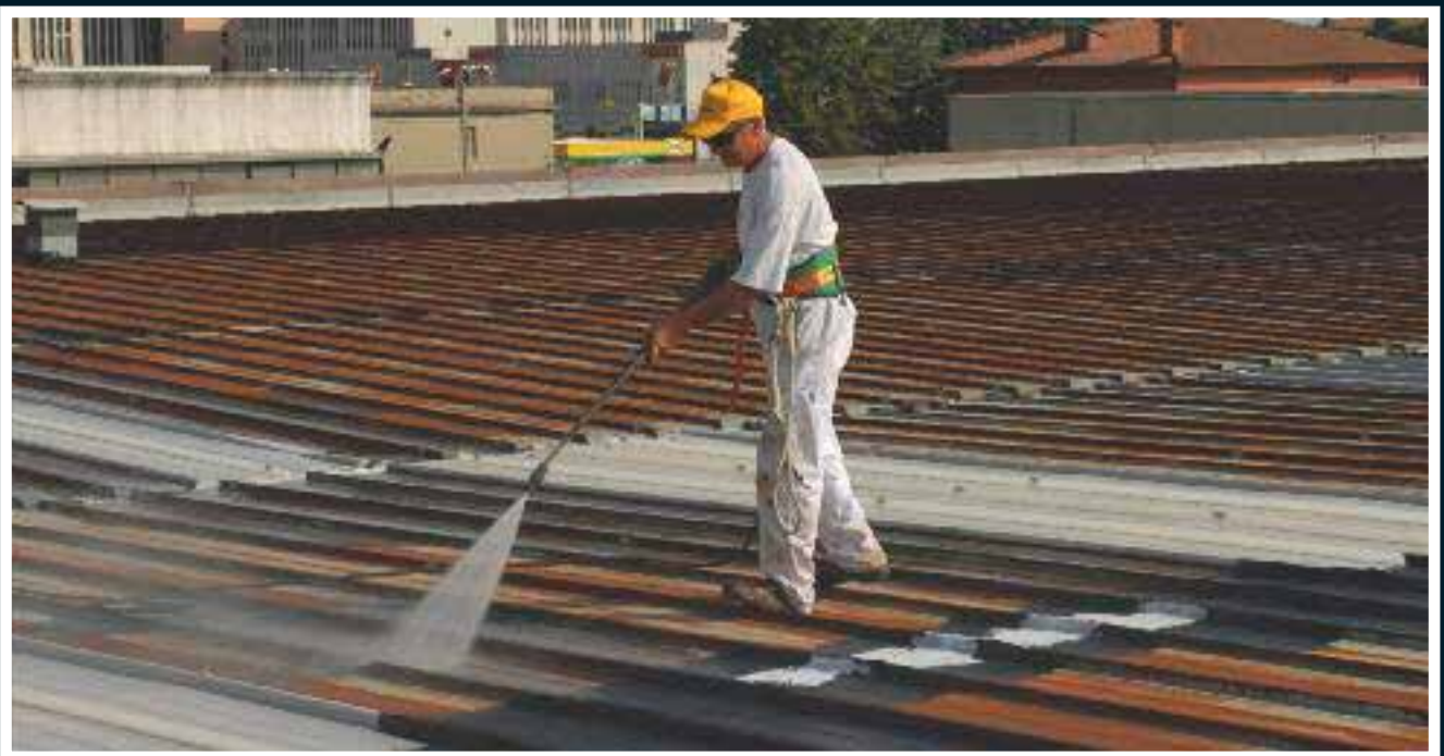
Primera fase de limpieza con hidrolimpiadora de alta presión para eliminar la herrumbre, la suciedad, etc.
