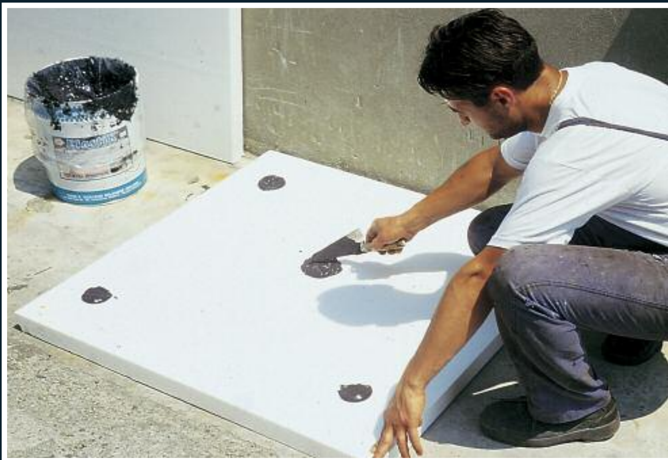
El encolado de paneles aislantes sobre superficies transpirantes (cemento, madera)
