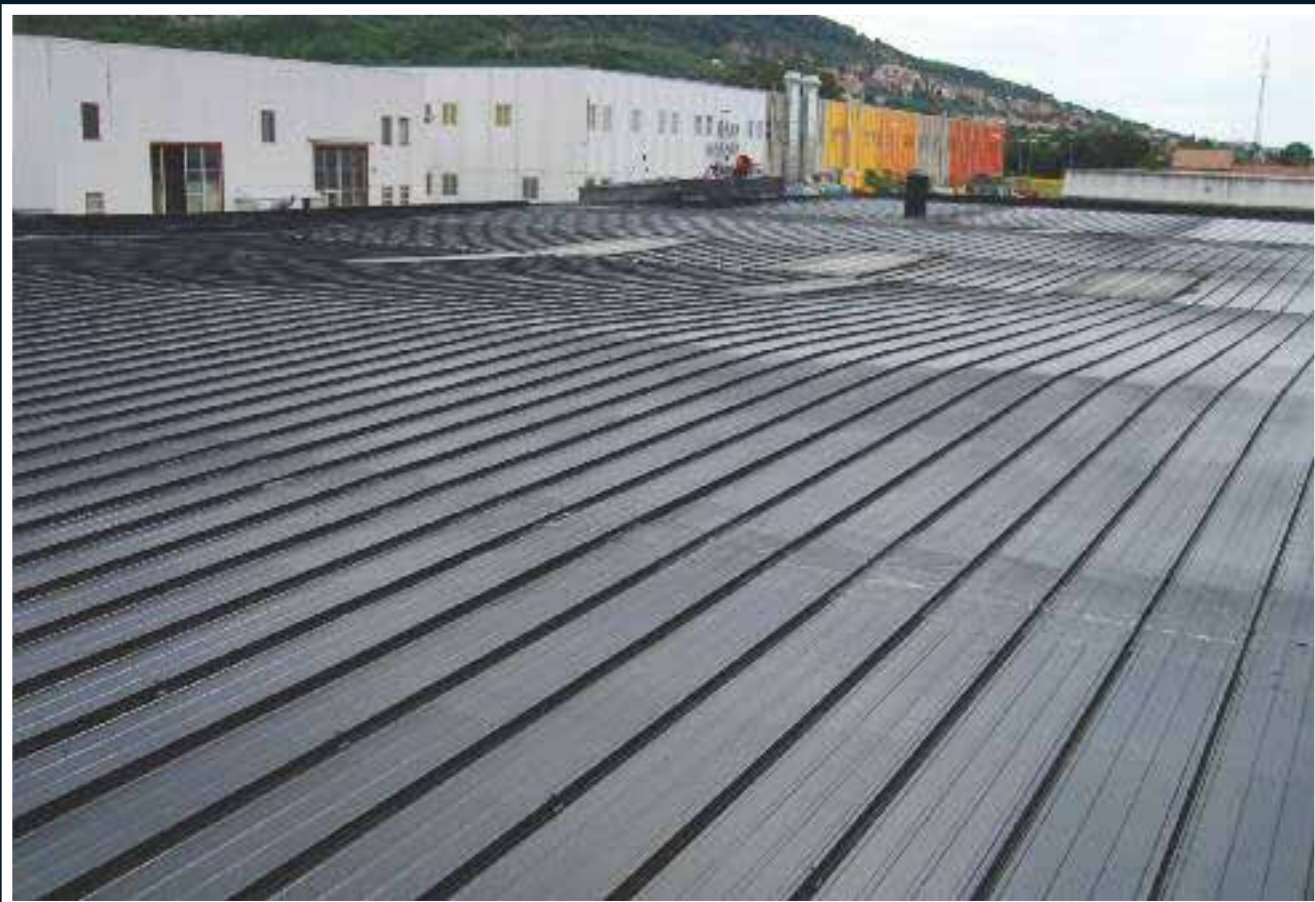
Aspecto de la cubierta metálica después del tratamiento hecho con dos manos de ElastiK con un intervalo de 48 horas entre una pasada y otra (aplicación con pistola con un consumo total de 1 kg/m 2 )
